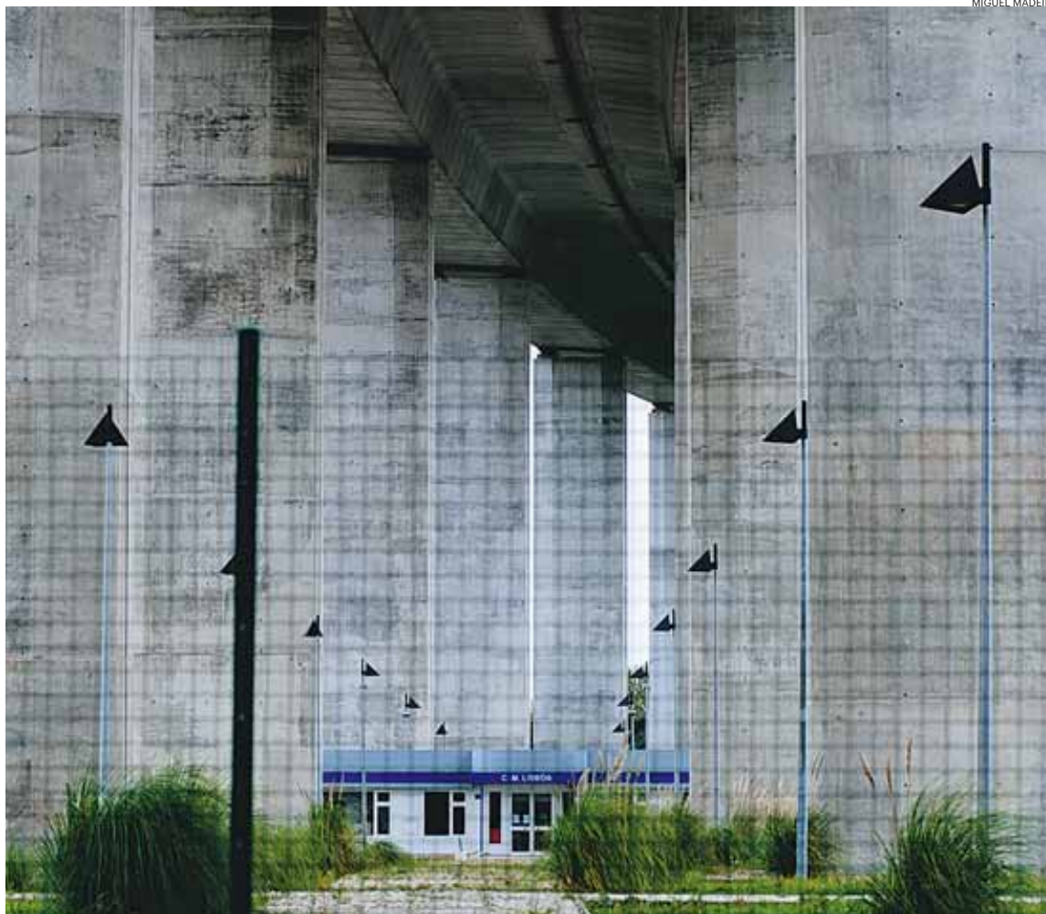
A Junta do Parque das Nações está a título provisório num contentor debaixo da Ponte Vasco da Gama
